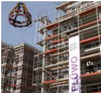
Die Flüwo feierte Richtfest am Alb-Carré
