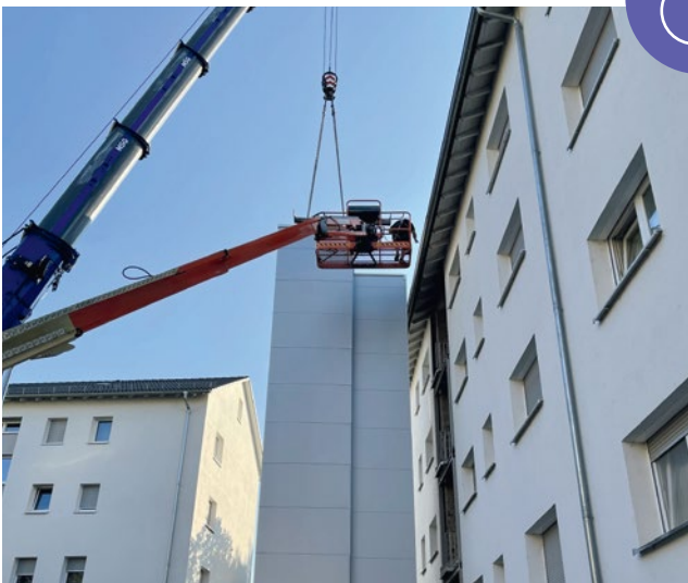
Karlsruhe, Herzstraße, Aufzugsanbau in Modulbauweise
