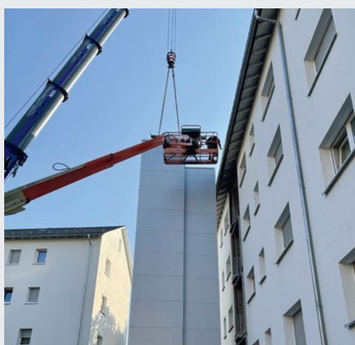
Karlsruhe, Herzstraße, Aufzugsanbau in Modulbauweise
