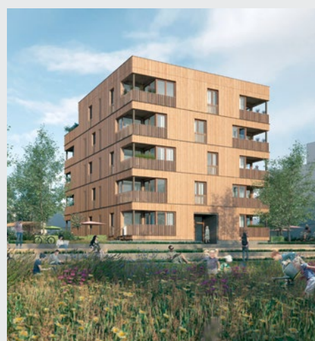
Mannheim, Neubauprojekt Spinelli Solitärgebäude, Holzskelettbauweise
