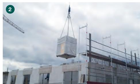
**1 + 2** Aus dem Bautagebuch: Eine Bodenplatte wird unter Wasser betoniert und Fertigbäder schweben durch die Luft.
