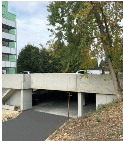
Mehr Platz fürs Auto: Der vorhandene Parkplatz wurde mit einem Parkdeck überbaut.
