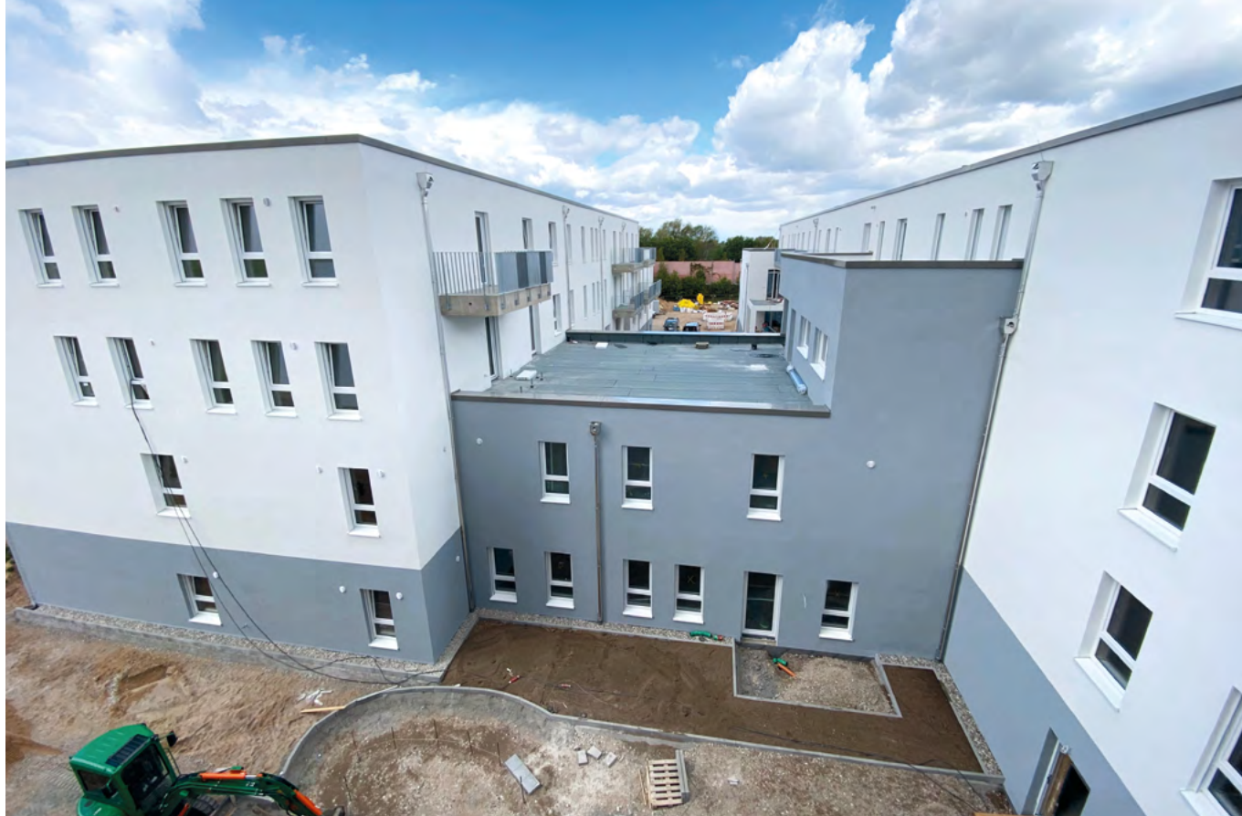
Am Pflegezentrum werden derzeit die Außenanlagen mit Bepflanzung und Wegen angelegt.
