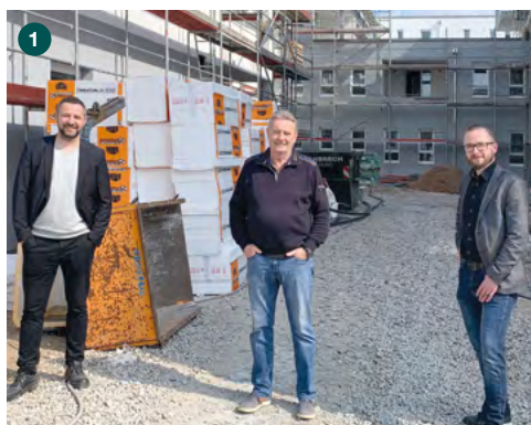
1 Zufriedene Gesichter beim Rundgang durchs Pflegezentrum:
