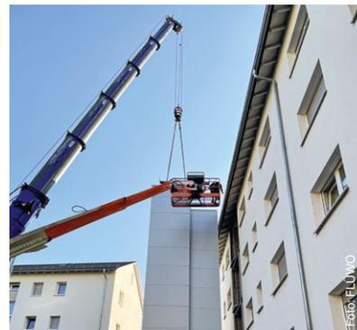
Mithilfe eines Autokrans wurde der fertig montierte Aufzugsturm am Gebäude angebracht.
