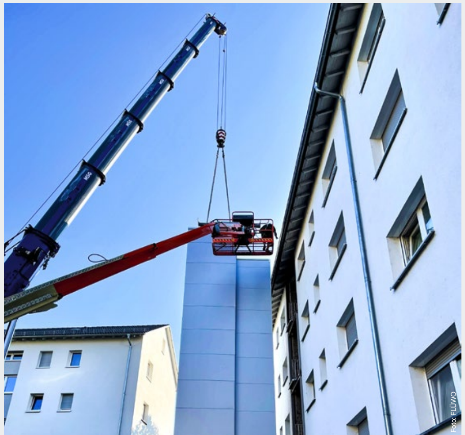
Karlsruhe, Herzstraße, Aufzugsanbau in Modulbauweise.
